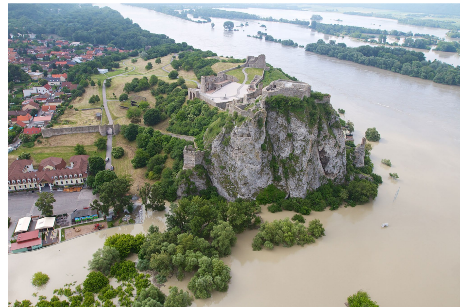
Povodeň v roku 2013 úplne zatopila vodomernú stanicu. Zdroj: SVP š. p.
